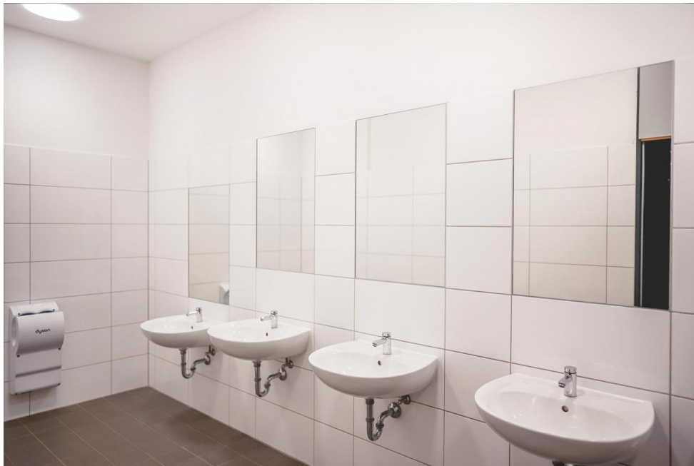
Neue Sanitäranlagen mit in den Fliesenspiegel integrierten Spiegeln
