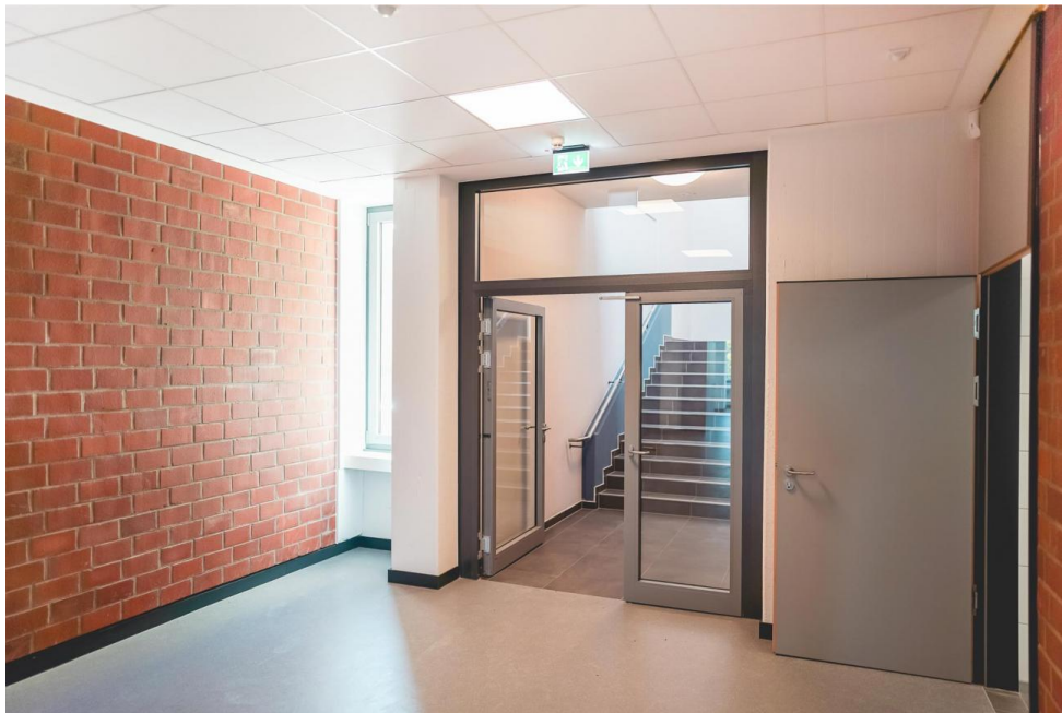
Brandschutztüren trennen die Treppenhäuser von den Unterrichtstrakten
