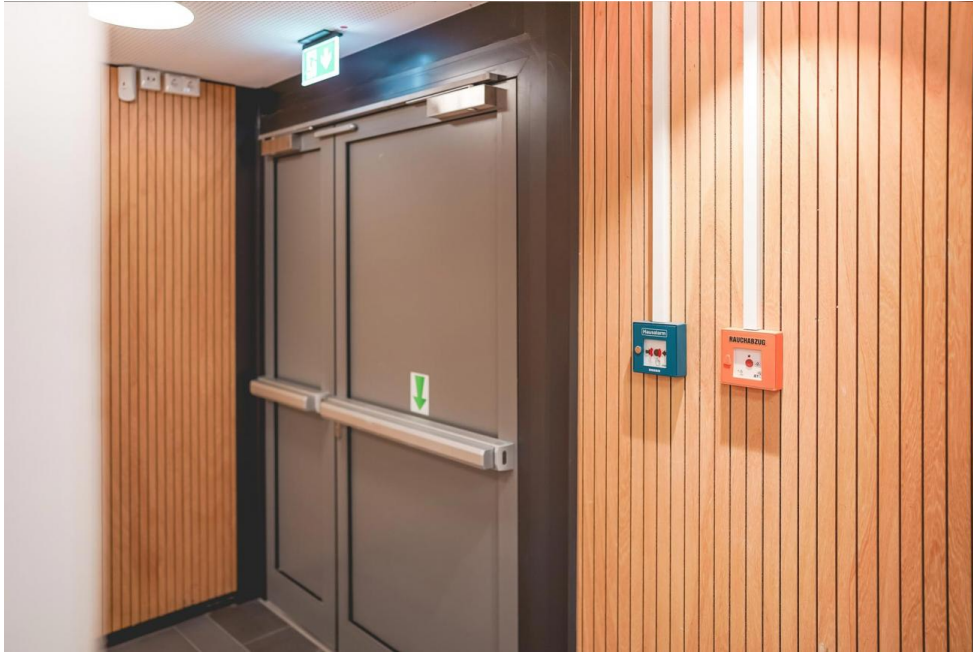
Fluchttüre mit Brandschutzeinrichtung
