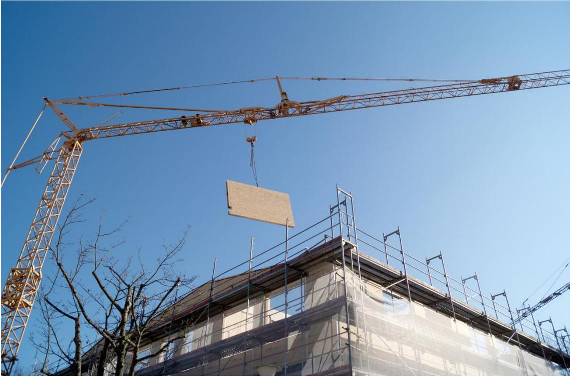
Bau der Fassade mit hinterlüfteter Holzbekleidung
