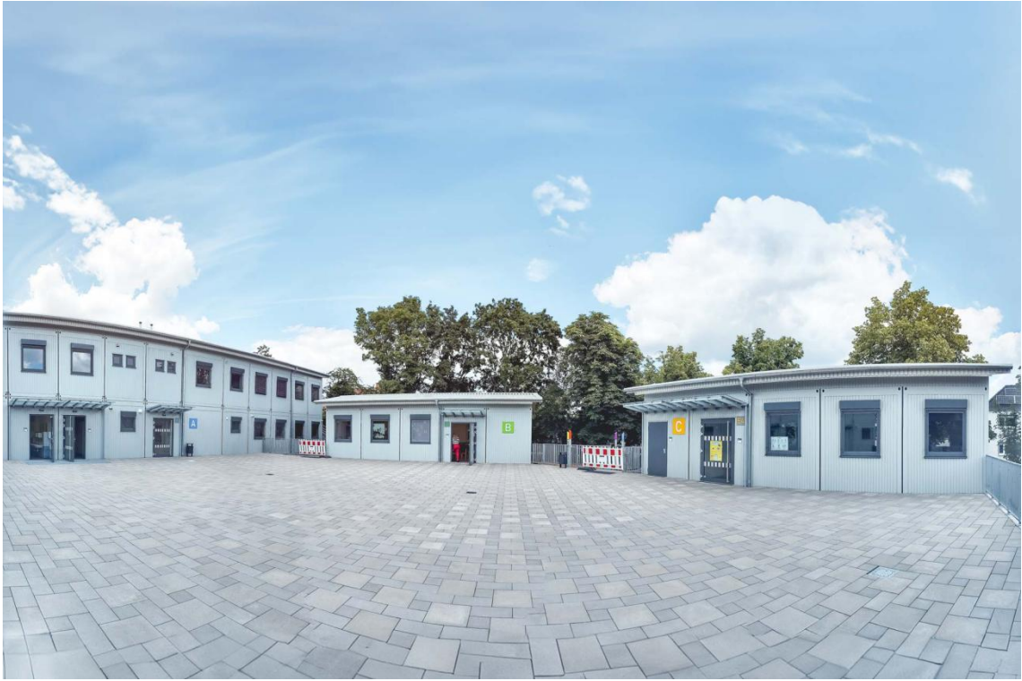
Gebäudeensemble des Container-Neubaus in Rheinbach
