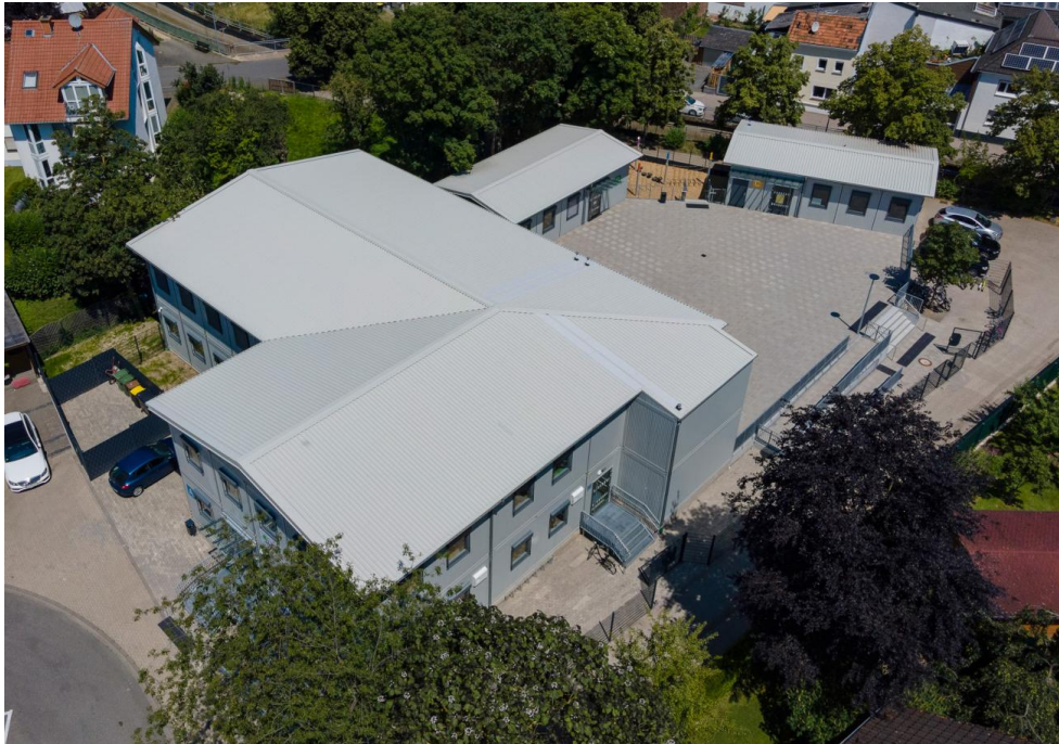
Luftansicht des Neubaus - Foto: Losberger De Boer
