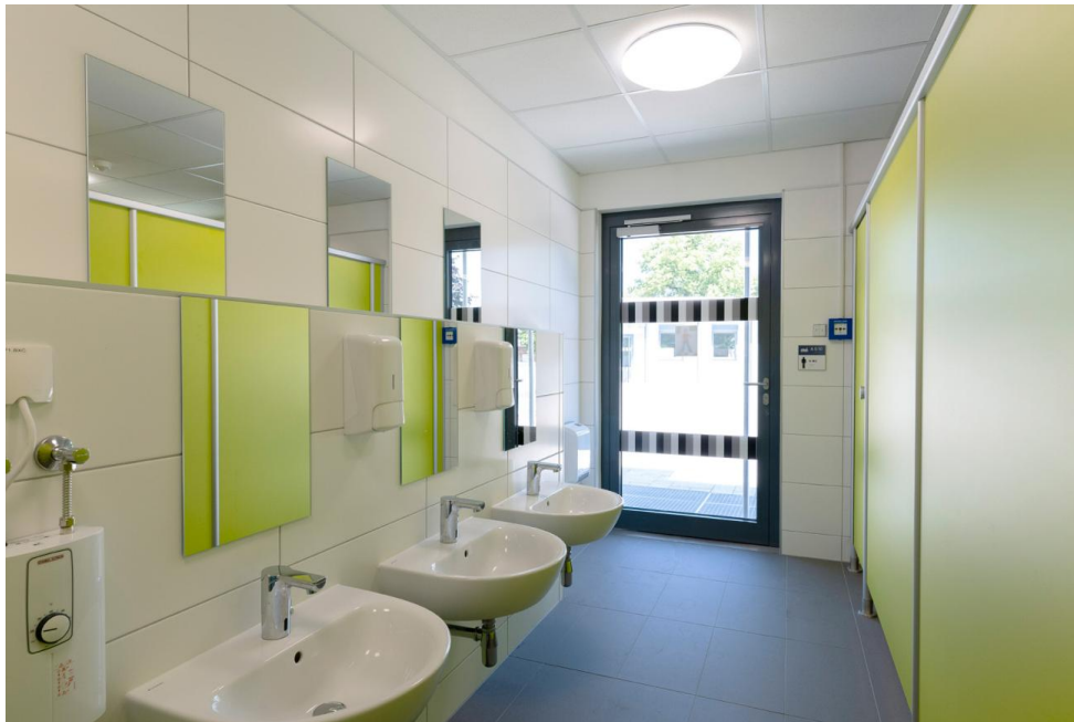
Sanitäranlagen - Foto: Losberger De Boer
