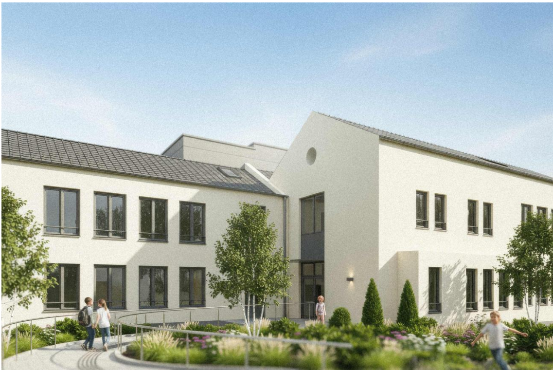
Bestandsgebäude der Grundschule nach Sanierung
