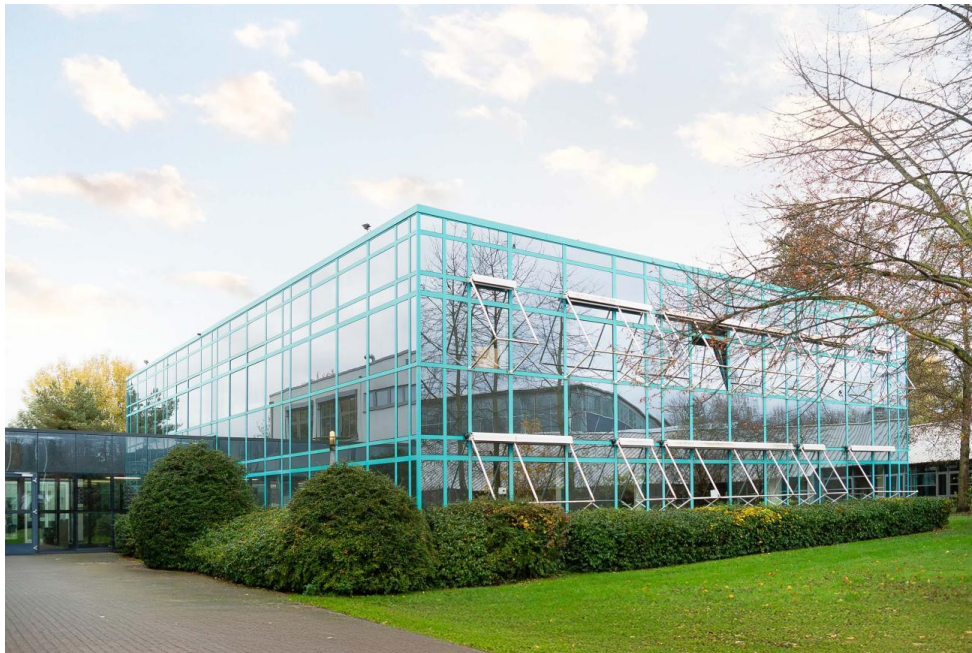
Brandschutzsanierung Modernisierung Glasfachschule in Rheinbach
