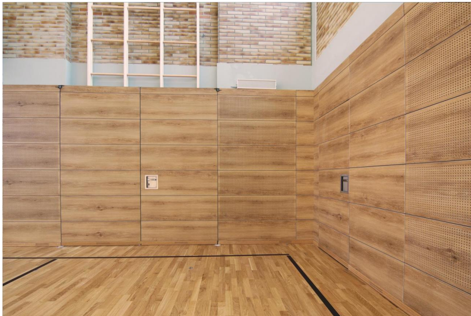
Neue Holzverkleidung der Turnhallenwände
