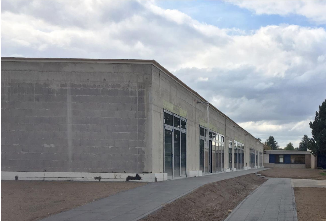
Rohbau Erweiterung Kaplan-Kellermann-Realschule
