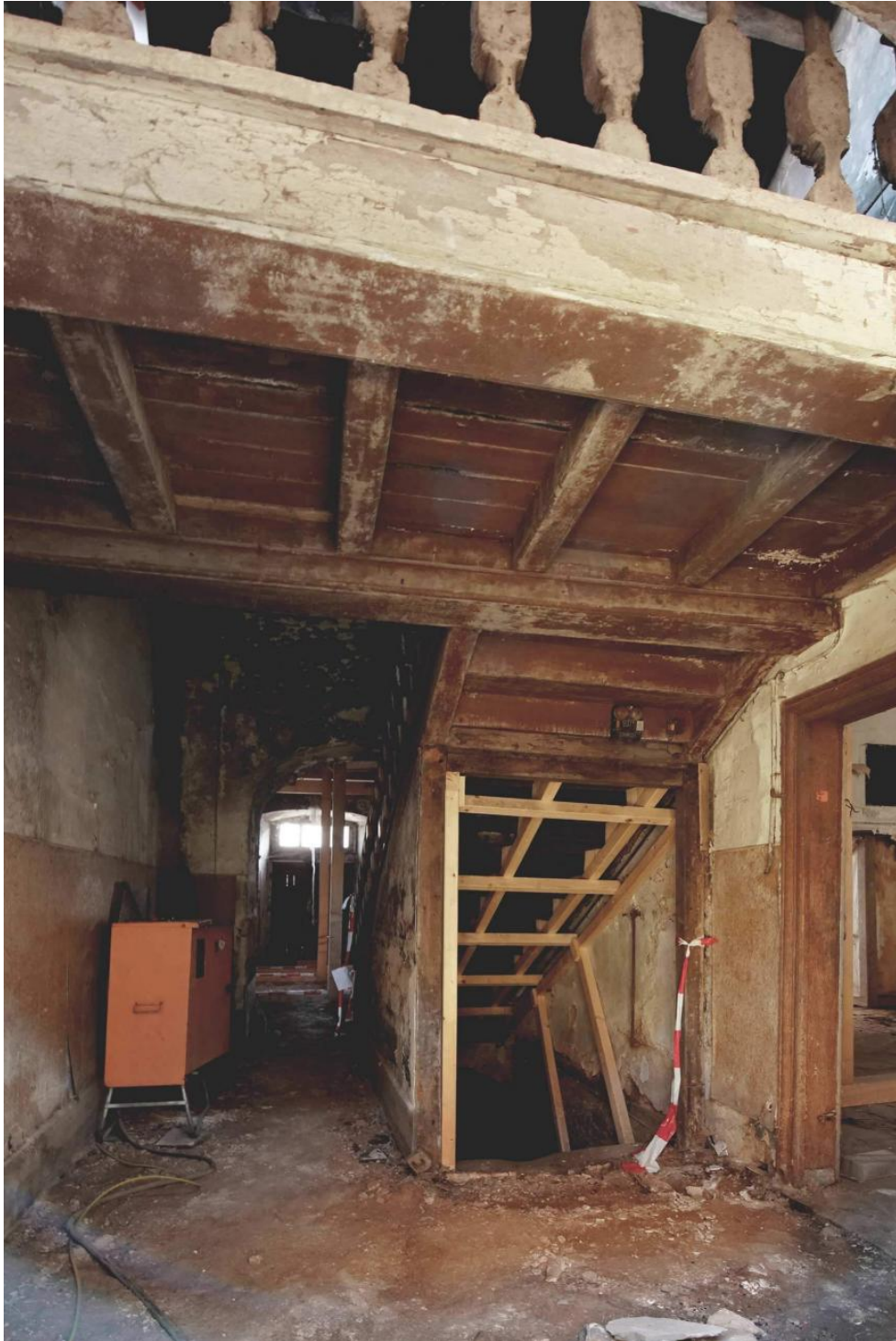
Rückansicht der gestützten Treppe
