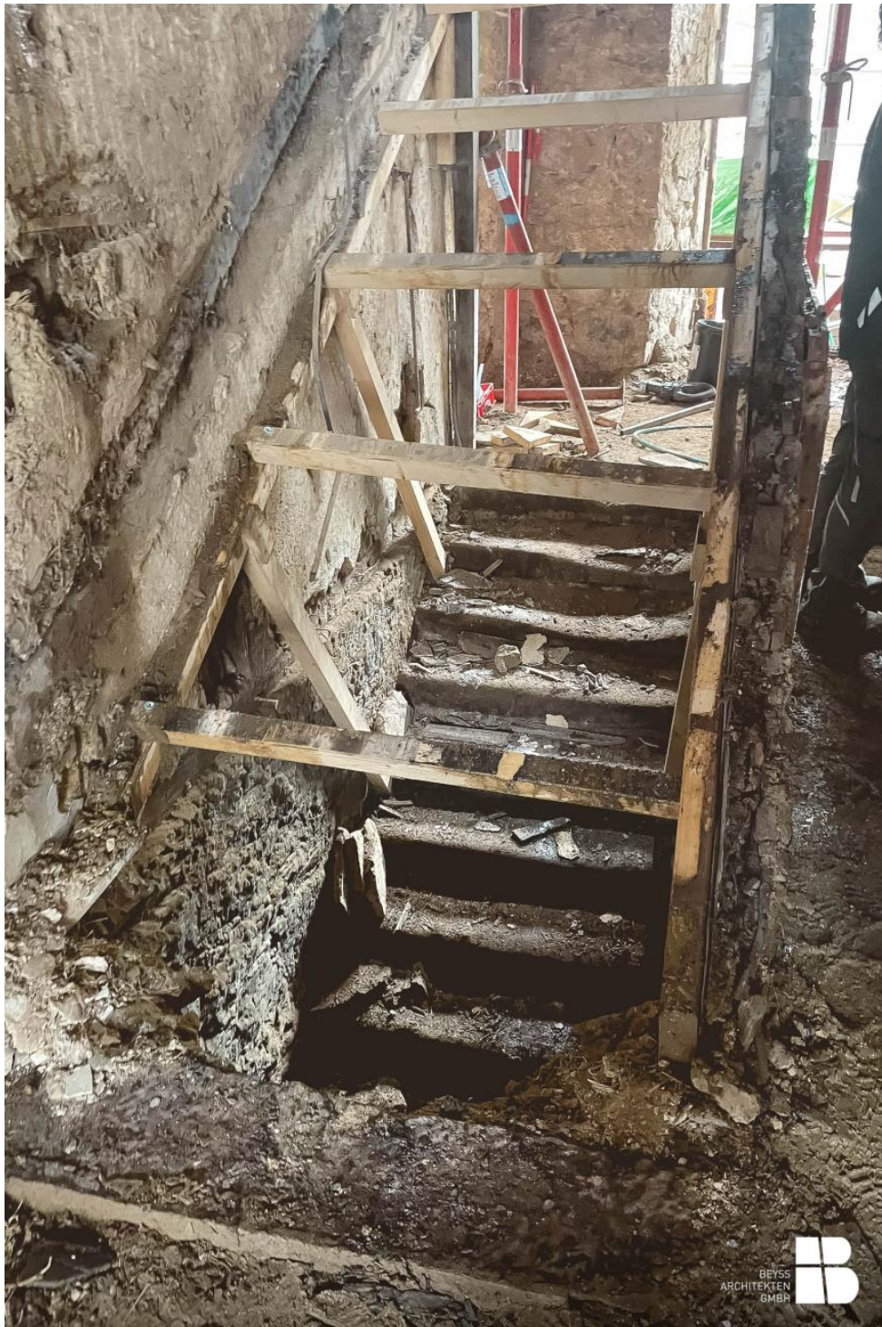
Nach Abtragung der denkmalgeschützten Treppe. Sichtbar ist nur die alte Steintreppe in den Gewölbekeller
