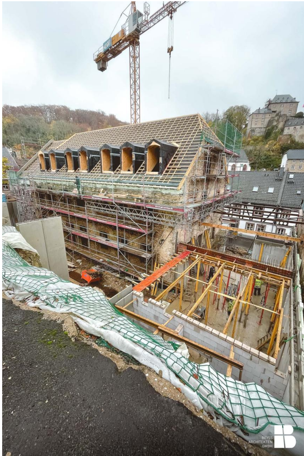
Das Dach wurde neu aufgebaut. Zudem wurde der linke Anbau abgerissen. Die Vorbereitungen zur Errichtung des Neubaus haben begonnen.
