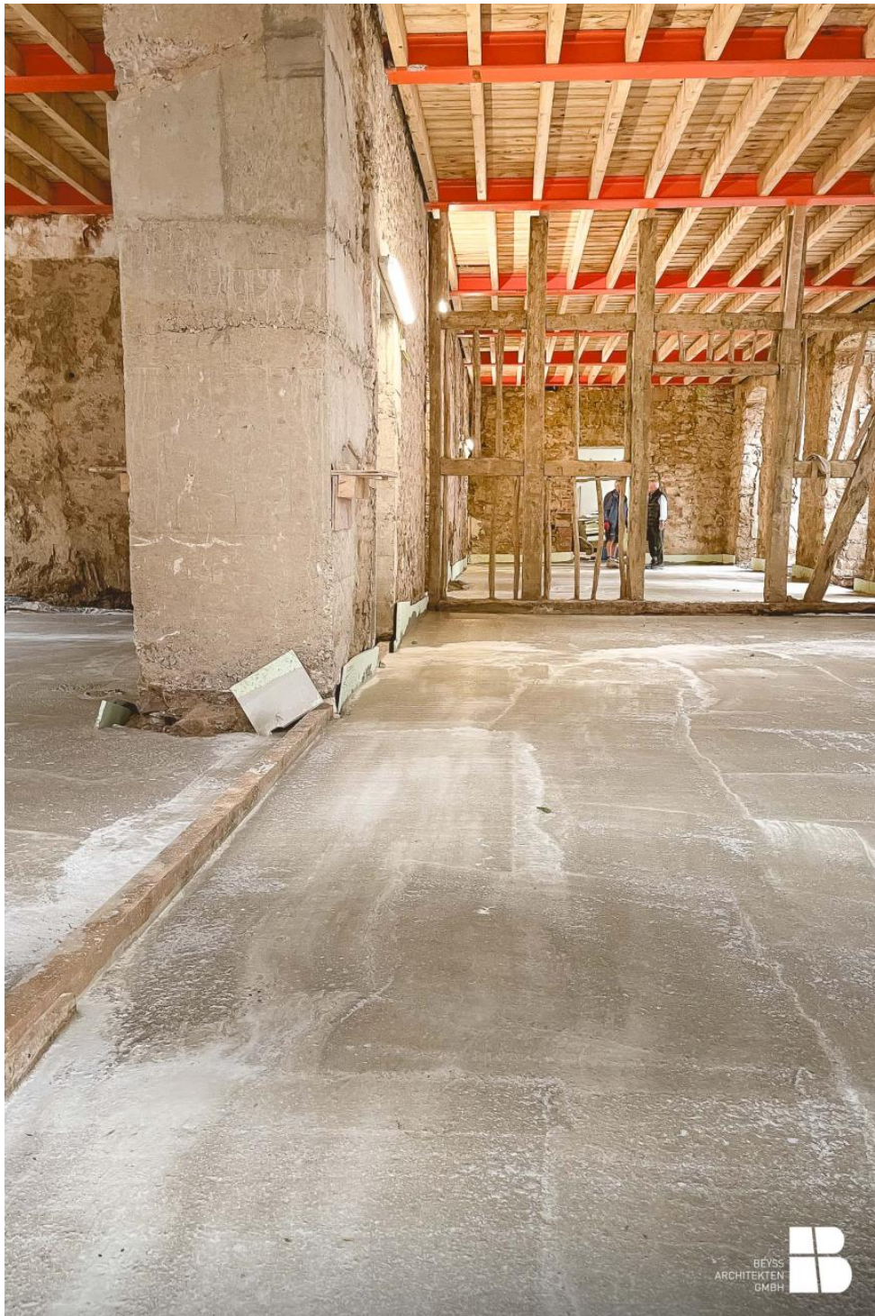
Das Erdgeschoss mit neuem Bodenaufbau und Geschossdecken
