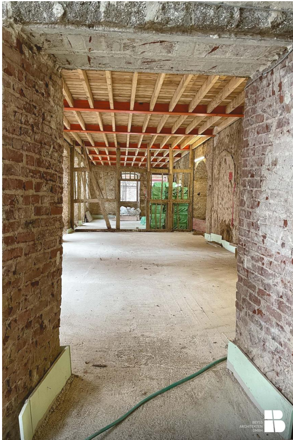
Durchgang im Erdgeschoss mit neuem Bodenaufbau und Geschossdecken
