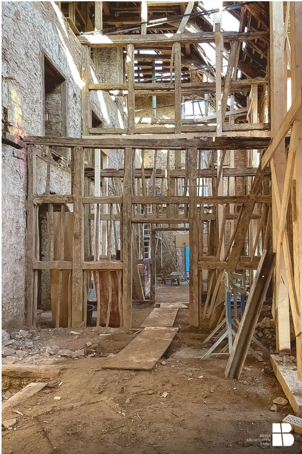
Nach Abbruch des Inneren sowie aller Etagenböden
