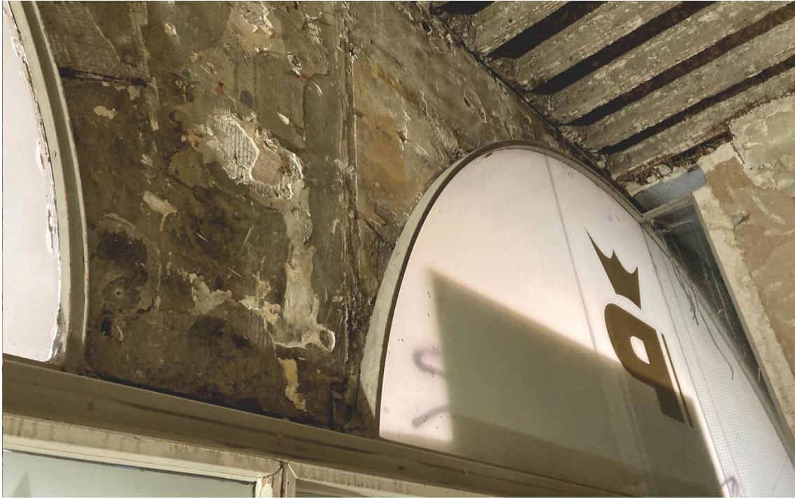
Innenansicht auf die alten Puppenkönig-Fenster
