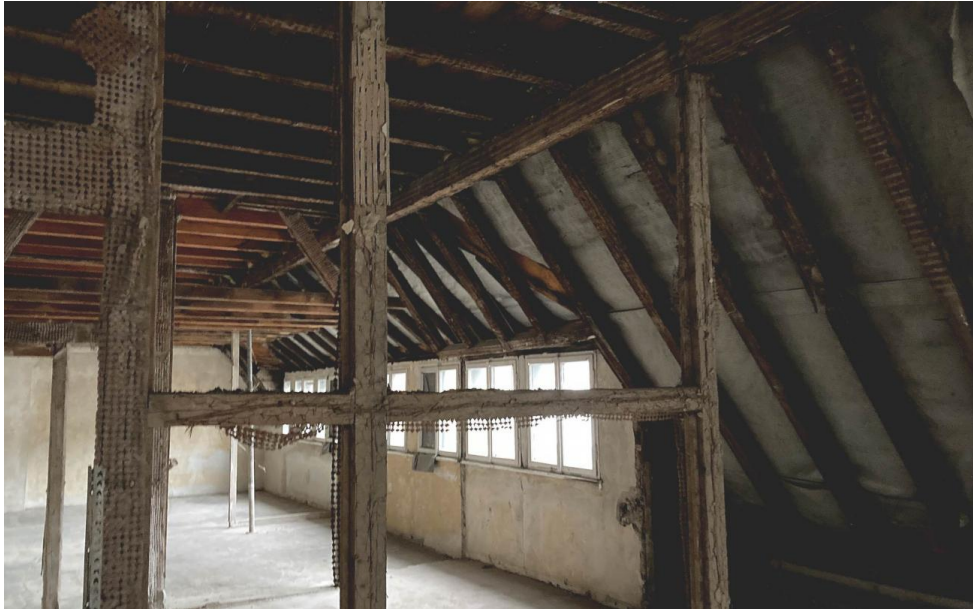
Die Büroräume der Franziskaner vor den Umbauarbeiten
