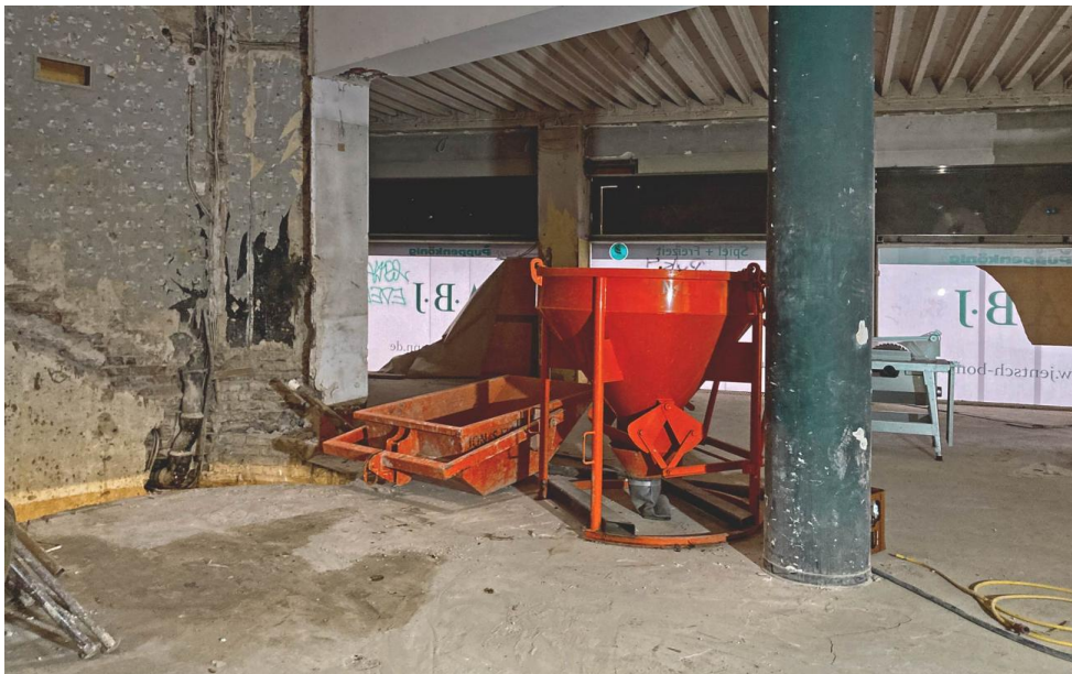
Innenansicht der Verkaufsraum-Baustelle
