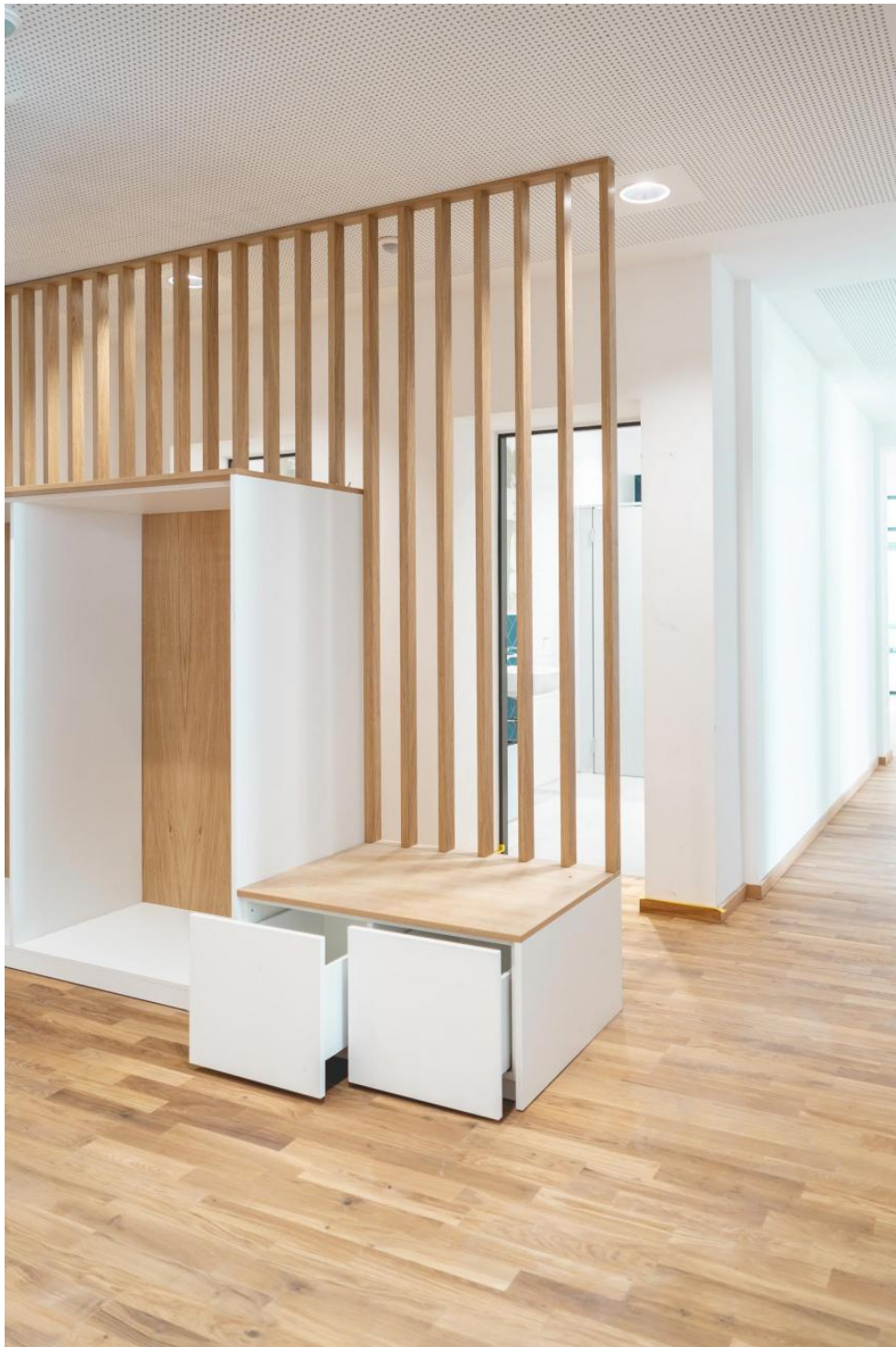
Einrichtung eines maßangefertigten Rauntrenners mit Garderobe
