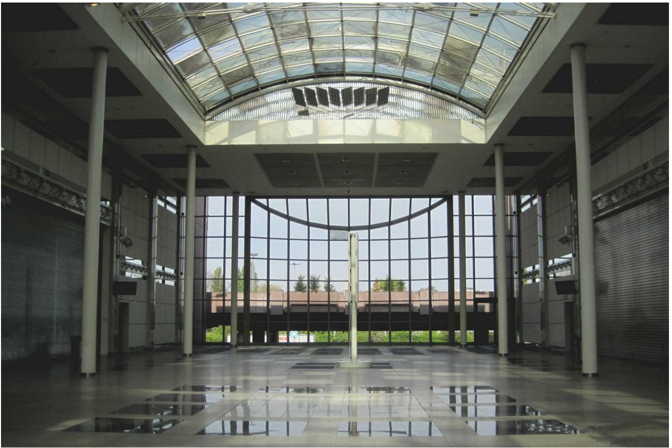
Zustand vor Beginn der Sanierungsarbeiten
