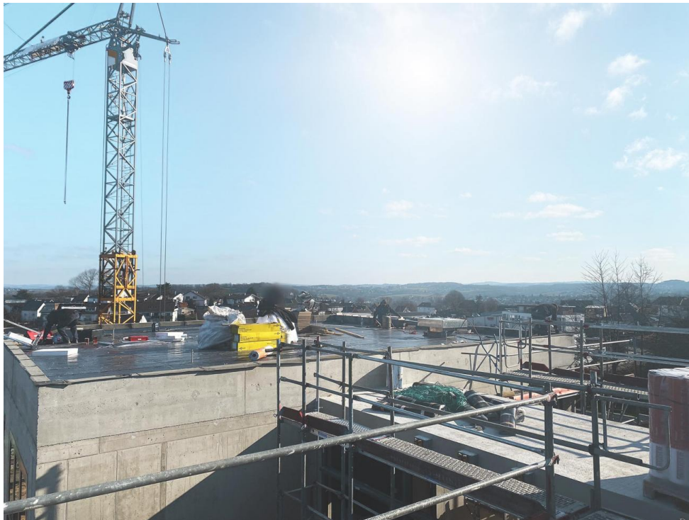
Aussicht vom Dach der Kindertagesstätte
