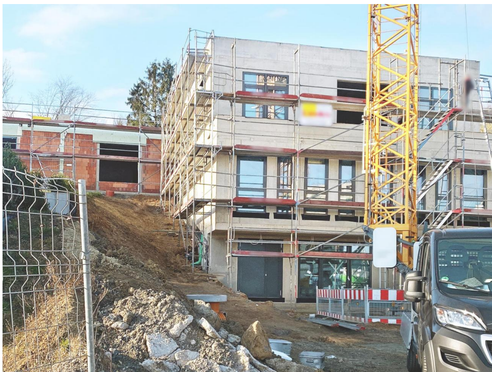
Straßenseitige Ansicht auf den dreigeschossigen Gebäudeteil mit Eingangsbereich
