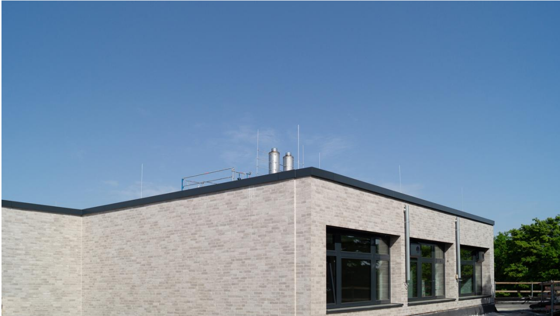
Beys Architekten WHG Sanierung Dach Fassade
