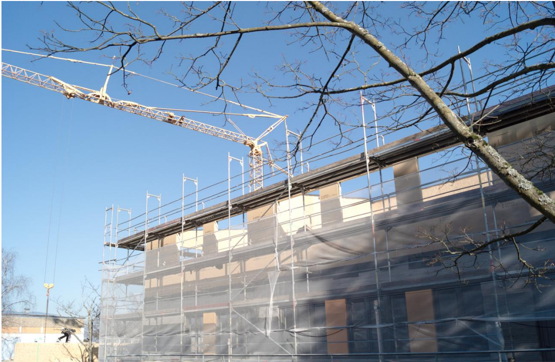
Fenster werden optisch in Fensterbänder gegliedert
