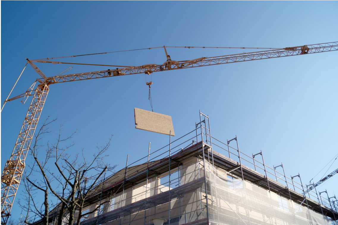
Bau der Fassade mit hinterlüfteter Holzbekleidung
