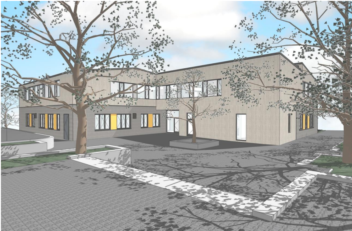
Aufstockung erfolgt in Holzbauweise
