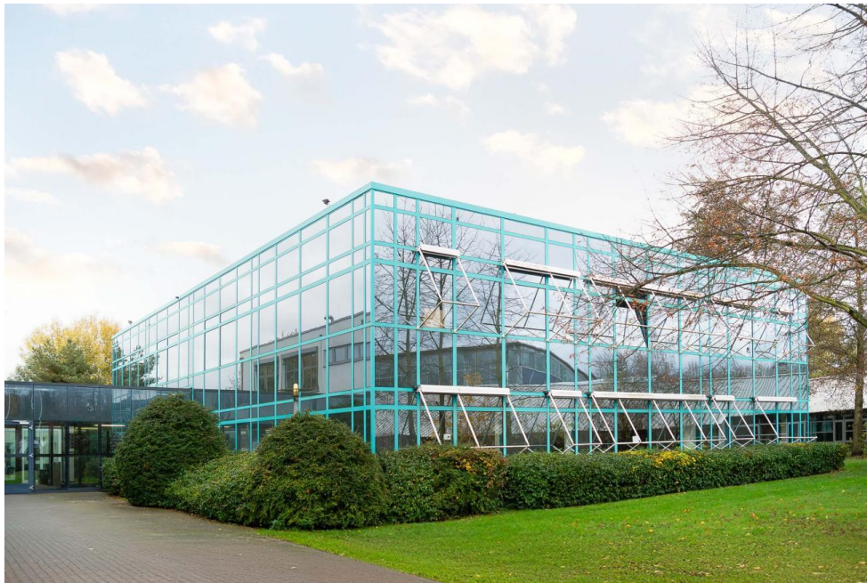
Brandschutzsanierung Modernisierung Glasfachschule in Rheinbach
