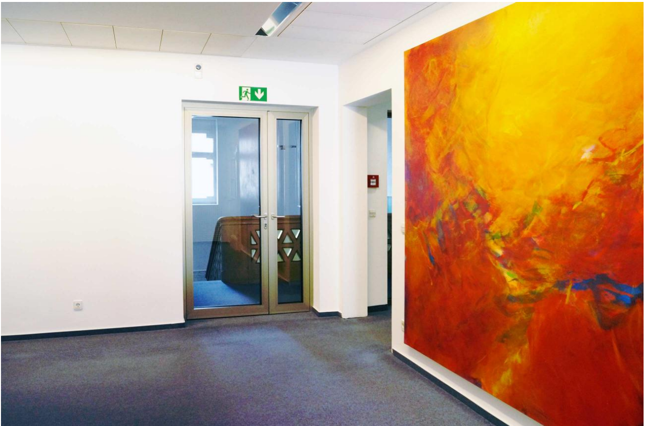
Treppenhausabschluss mit neuer Brandschütztüre
