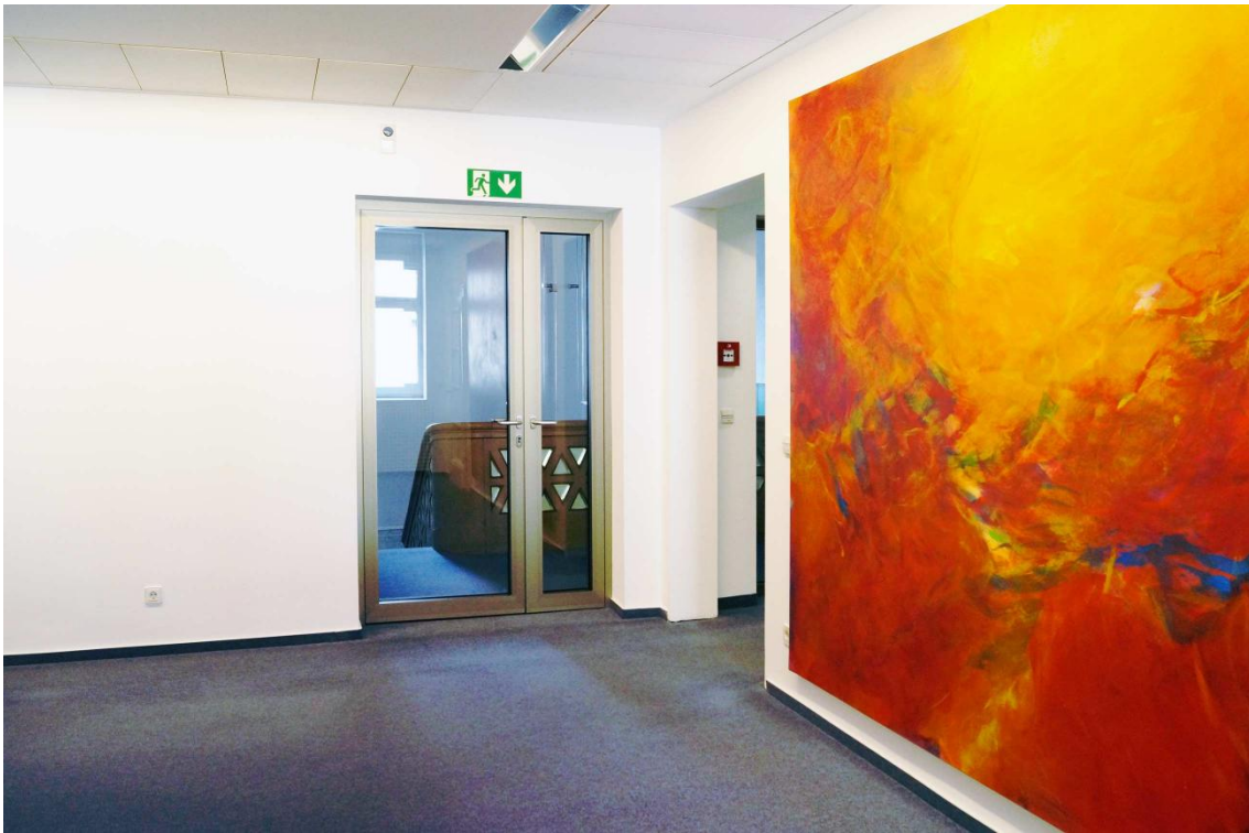
Treppenhausabschluss mit neuer Brandschütztüre
