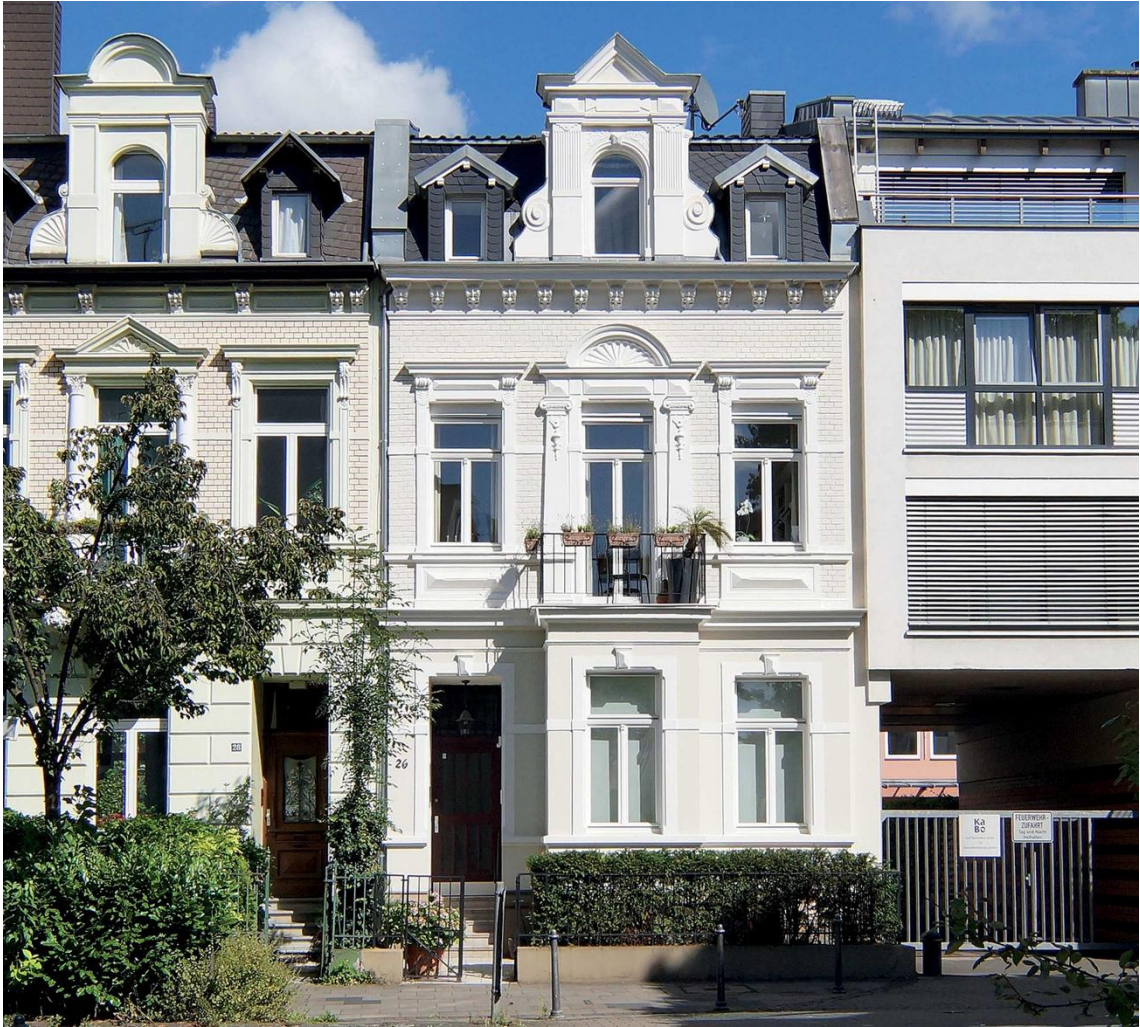
Umbau und Modernisierung Mehrfamilienhaus in Bonn
