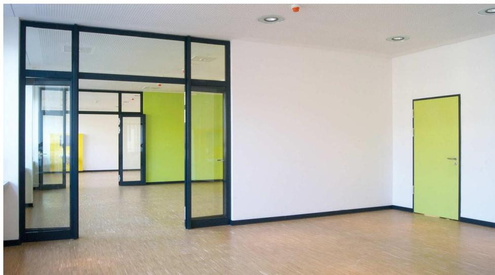
Glaswände ermöglichen in den umgestalteten Bestandsgebäuden eine flexible Nutzung der Räumlichkeiten.
