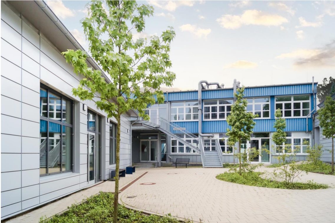
Sanierung und Erweiterung Berufsschule Solingen (TBK)
