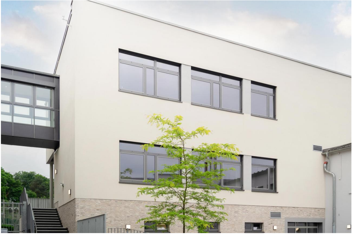
Neubau mit Verbindungsbrücke am Technischen Berufskolleg Standort Weyers
